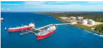
Terminal de Combustibles
